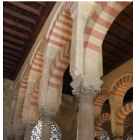
図11 創建部分の修復されたアーチ。イン ポスト上にイスラームのものとは異なる細部
