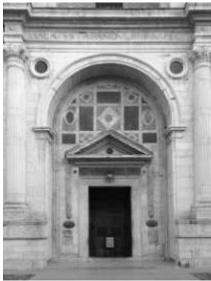
図4 テンピオ・マラテスティアーノ 西正面扉口
