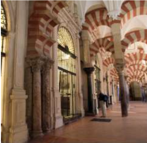
図 20 創建モスクからアルマンソール増築部 へアクセスする多葉形アーチと円柱（手前） 小ピッチの円柱間を結ぶ三葉形アーチ（奥）
